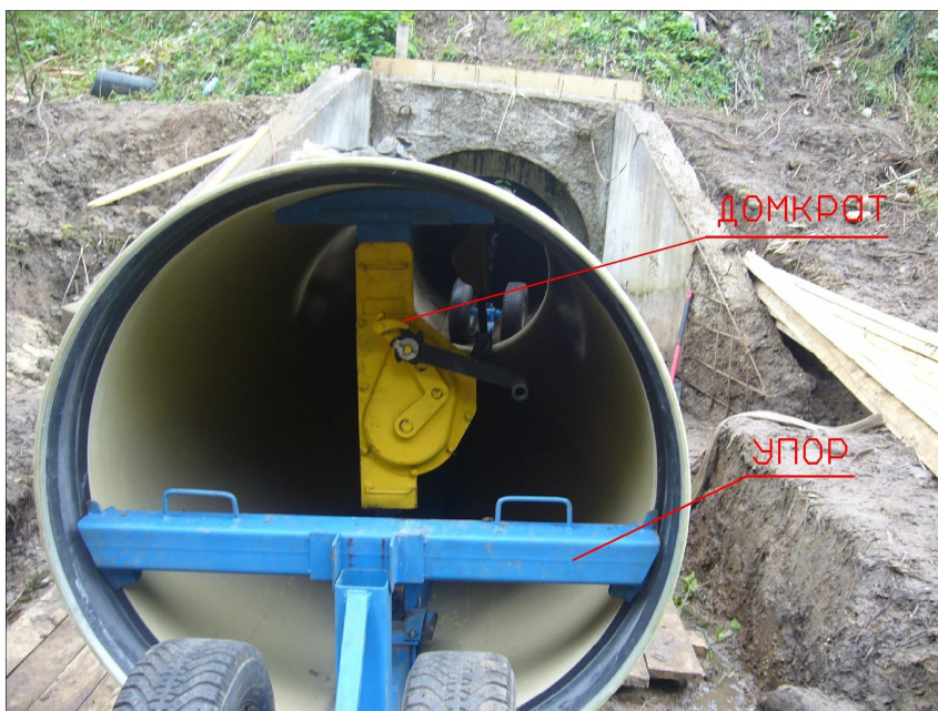
Рисунок Б.1 - Установка монтажной тележки с домкратами и упора
