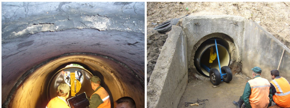
Рисунок Б.2 - Монтаж I звена
