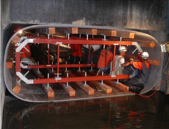
Фотография В.1 - Устройство опалубки внутри оболочки из ПВХ-профиля (вариант)
